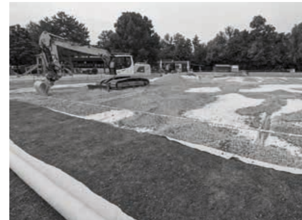
30.06.2023: Das Trennfließ, der Kies sowie die Drainageleitungen wurden gelegt.
