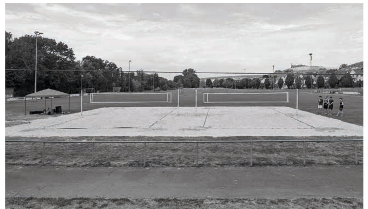
16.07.2023: Installation der Netze sowie der Begrenzungen des Spielfeldes
