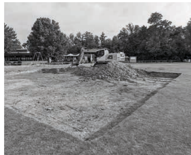
26.06.2023: Startschuss! Erste Grabungen des 26 x 24 Meter großen Lochs
