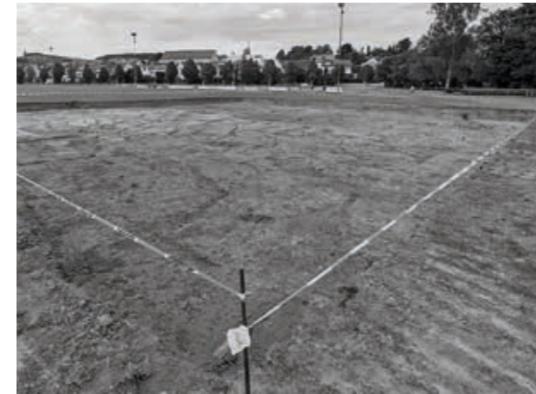
27.06.2023: Das Fundament ist ausgehoben.
