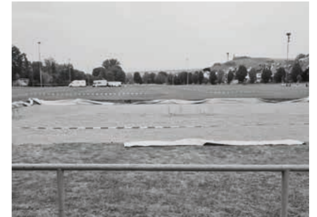
01.07.2023: Die Schalungen für die Fundamente stehen, sowie die Fertigstellung der Drainage.
